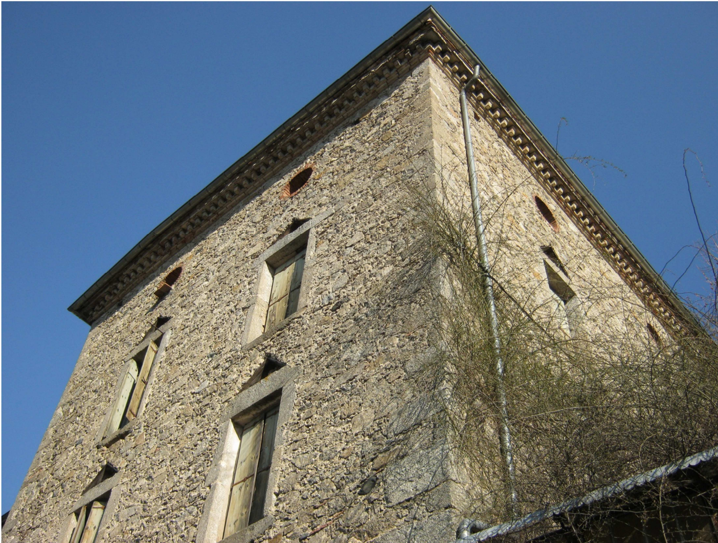
Le Pavillon Nord, On peut noter la présence de la brique pour marquer certain éléments comme les oculi ainsi que le débord de toiture en génoise.
